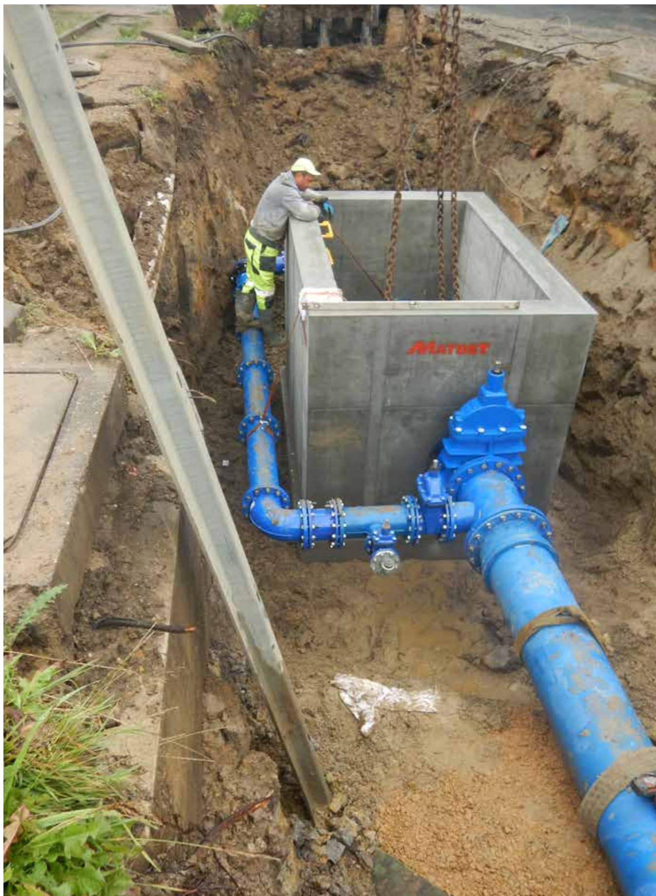
Przebudowa wodociągu w Częstochowie w ulicy św. Barbary, Głównej i Przejazdowej.
