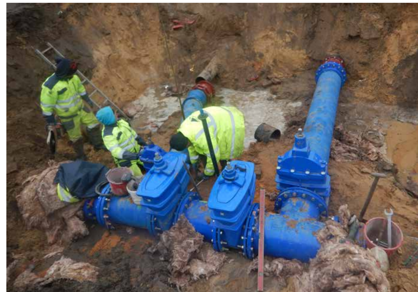
Przebudowa wodociągu w Częstochowie w ulicy św. Barbary, Głównej i Przejazdowej.
