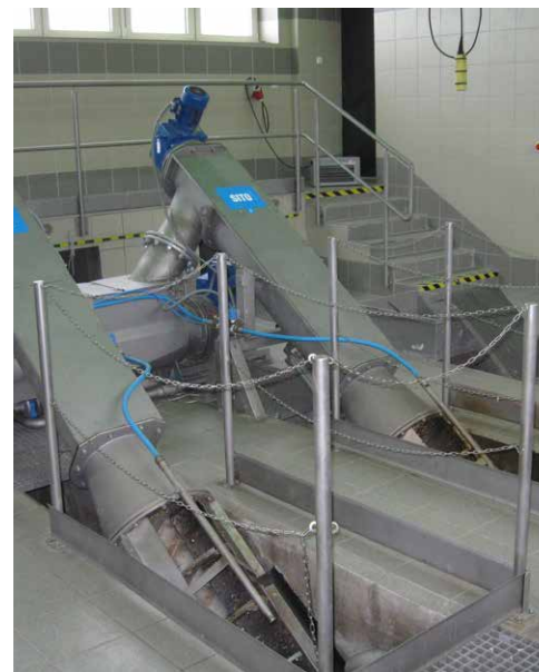
Osł Kłobuck mechaniczne oczyszczanie ścieków - sita spiralne
