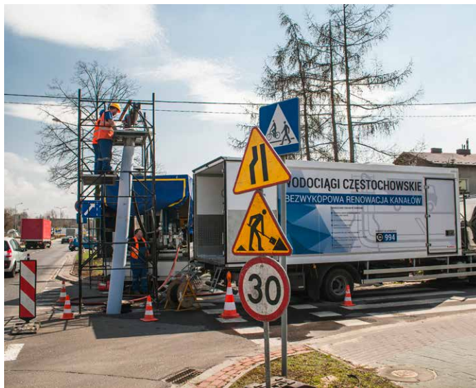
Realizacja bezwykopowej renowacji sieci kanalizacyjnej
