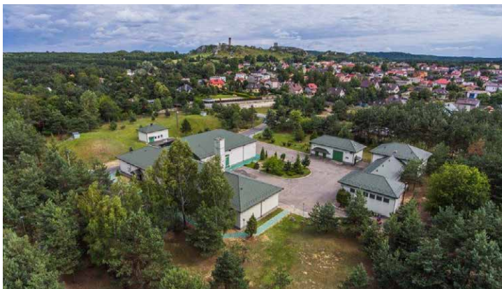
Ujęcie Wody Olsztyn – pompownia
