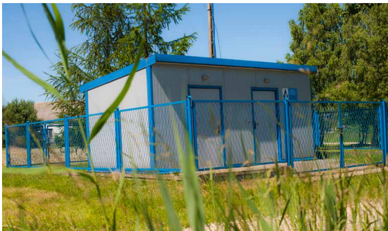
Jedna z wielu eksploatowanych przepompowni ścieków
