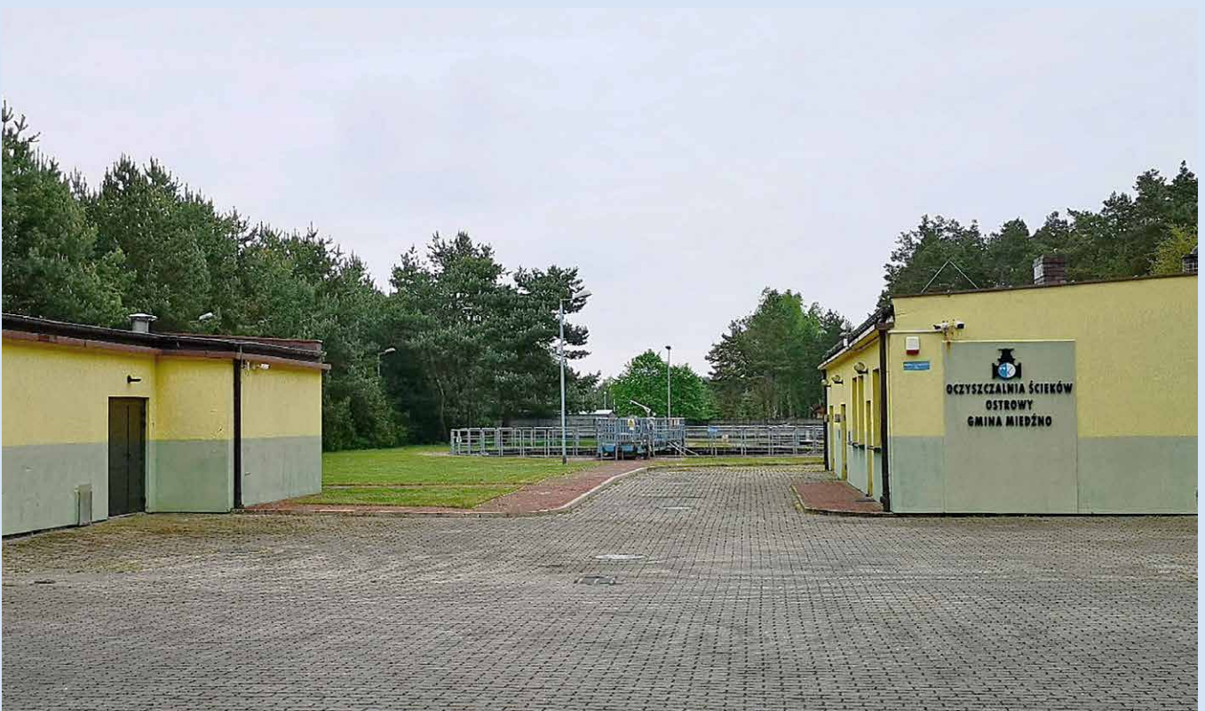
Oczyszczalnia Ścieków Ostrowy nad Okszą
