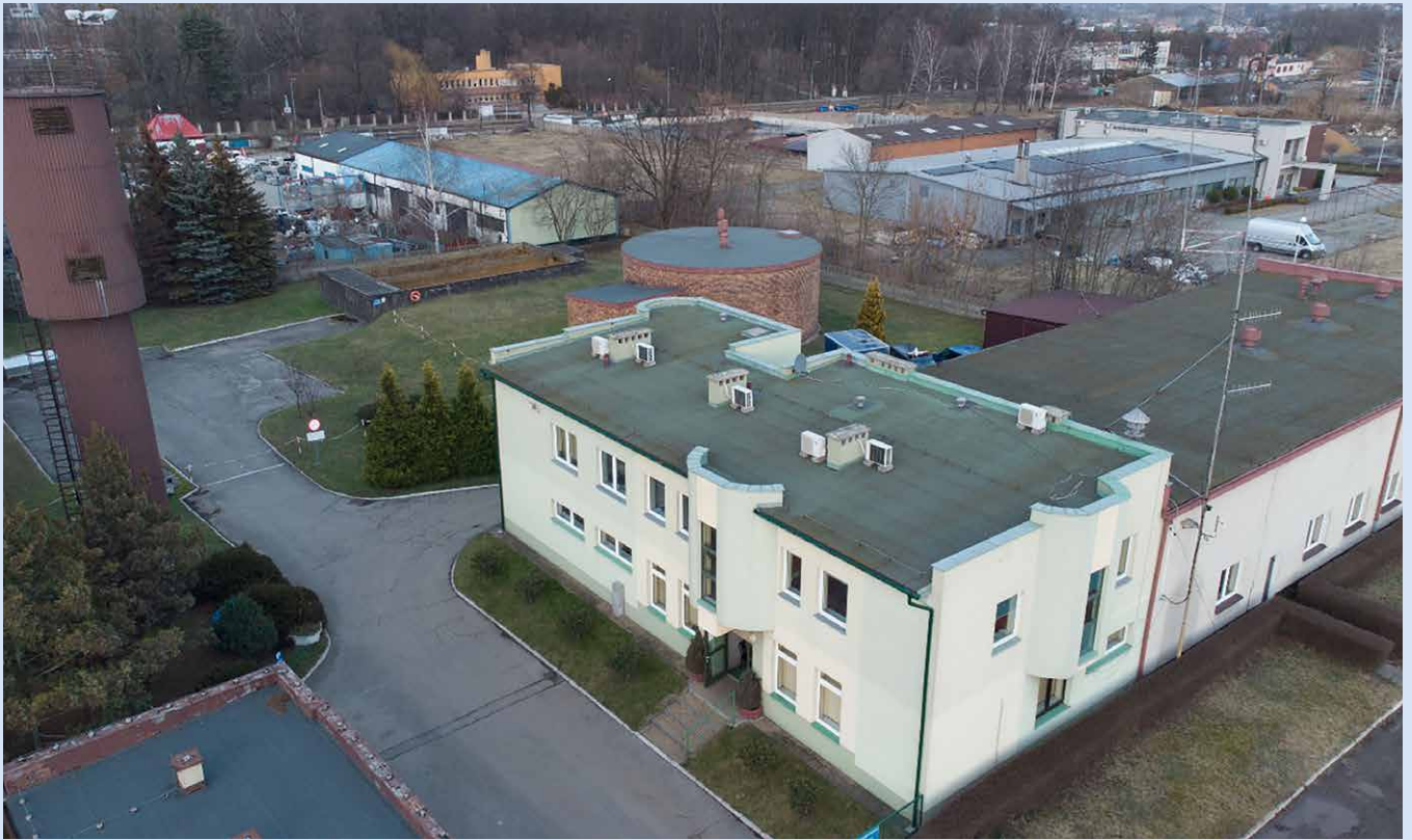
Ujęcie Wody Kłobuck
