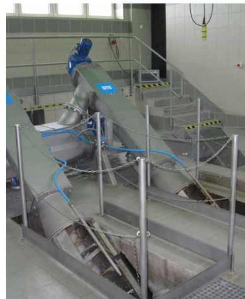
Osł Kłobuck mechaniczne oczyszczanie ścieków - sita spiralne
