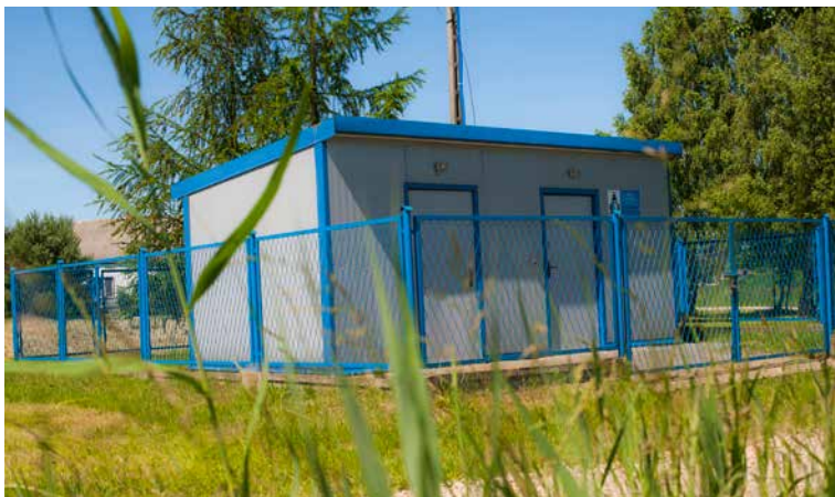
Jedna z wielu eksploatowanych przepompowni ścieków
