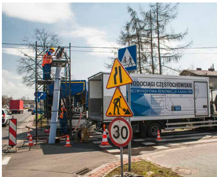
Realizacja bezwykopowej renowacji sieci kanalizacyjnej
