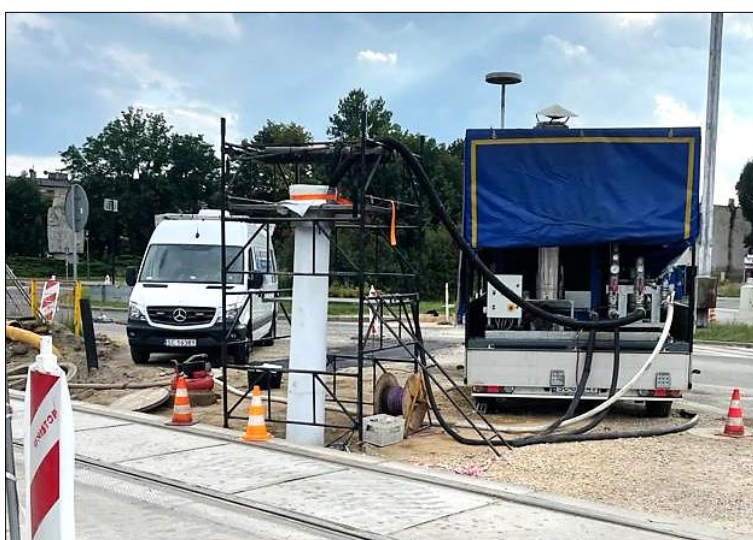
Ryc. 2. Typowa realizacja bezwykopowej renowacji kanalizacji – wprowadzanie „rękawa”
