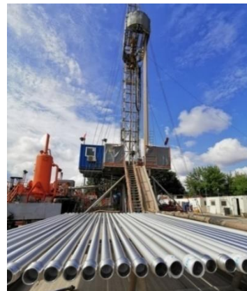
Ryc. 2. Kolumna filtrowa przygotowana do zapuszczenia do otworu
