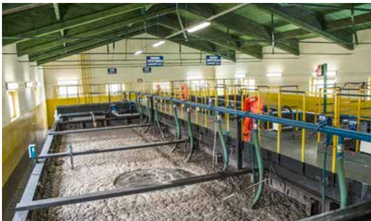
Oczyszczalnia ścieków w K. Poczesnej
