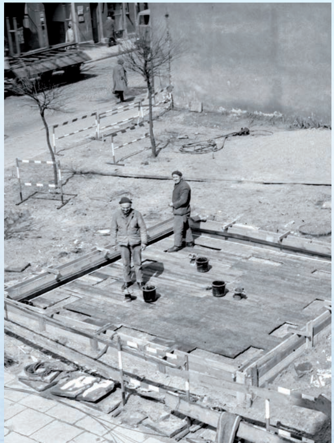
Budowa fontanny przed biurowcem.
