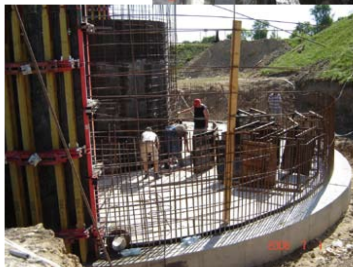
Budowa zbiornika stabilizacji i zagęszczania osadu
