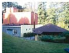
Kol. Wierzchowisko, ul. Zielona, gm. Mykanów – uzdatnianie wody (biologiczna denitryfikacja), dezynfekcja wody poprzez ozonowanie oraz stacja pomp.
