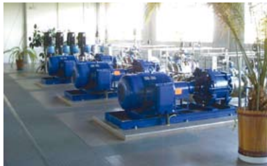
Ujęcie wody Łobodno - pompownia wody
