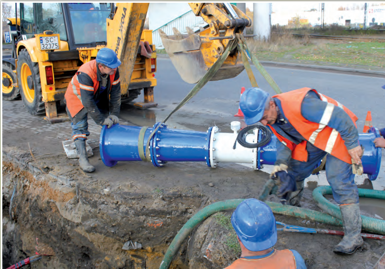
Rysunek 1. Montaż przepływomierza na wodociągu DN 400 w ul. Bór w Częstochowie
