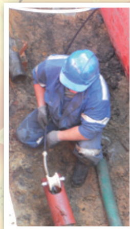
Wprowadzanie głowicy kamery do rozciętego wodociągu
