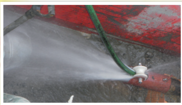
Wprowadzanie dyszy rotacyjnej do wodociągu z użyciem prowadnicy
