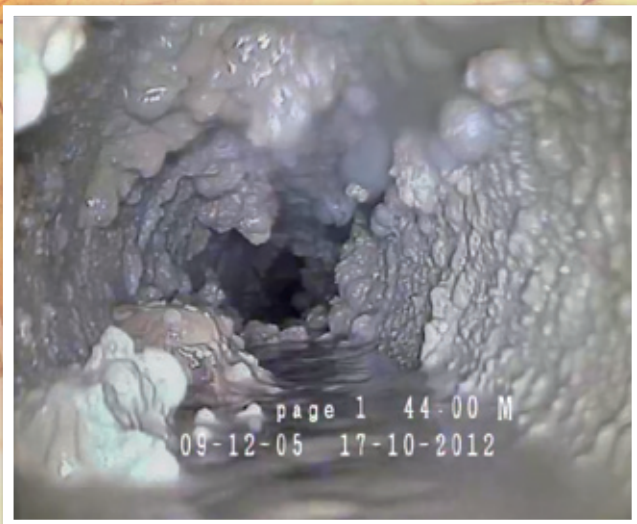
Wnętrze wodociągu żeliwnego DN 100 przed zrywaniem osadów
