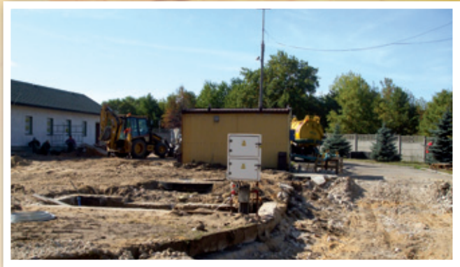
Plac budowy na terenie zlewni
